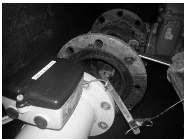
Obr. 2. Výměna kuponů na odtoku z VDJ Hodušín
